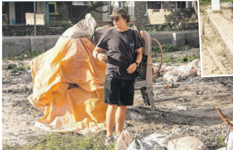
Nico Jeuch auf der Baustelle in Lamu. Das kleine Bild zeigt im Hintergrund den Prototypen. (Bilder: zvg)
